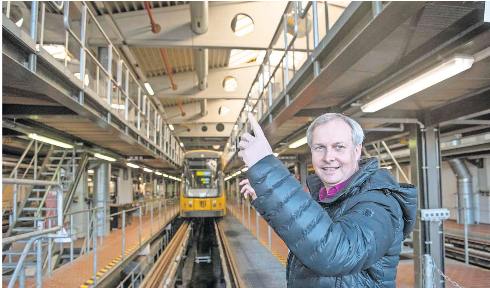
Im Betriebshof Gorbitz zeigt Holger Seifert, Chef der Schienenfahrzeuge der DVB, die Dacharbeitsstände. Die müssen so verändert werden, dass die neuen breiteren Bahnen durchpassen. FOTO: DIETRICH FLECHTNER
